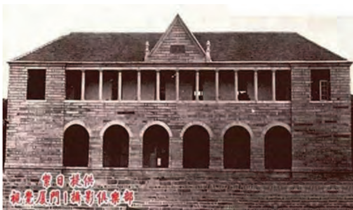
图1 1921年建的厦门大学笃行楼（照片来自网络）
